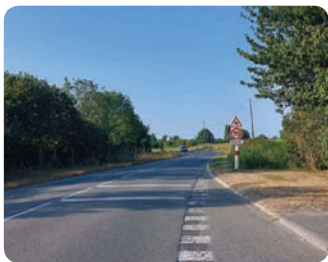
Mise en sécurité du virage de la RD 947, route de Bray-Dunes par le Département
