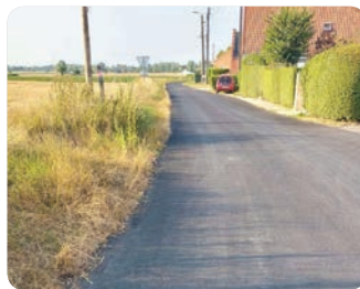
Pose d'une nouvelle couche de roulement sur le Chemin vert par Cœur de Flandre
