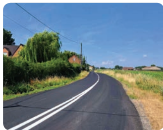
Rénovation de la route du Droogland par le Département
